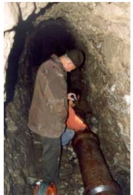
Abb. 8: Ortung der alten Tonrohrleitung
