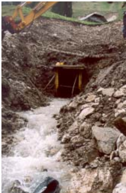
Abb. 5: Grabungsarbeiten mit Freilegung des Stolleneingangs
