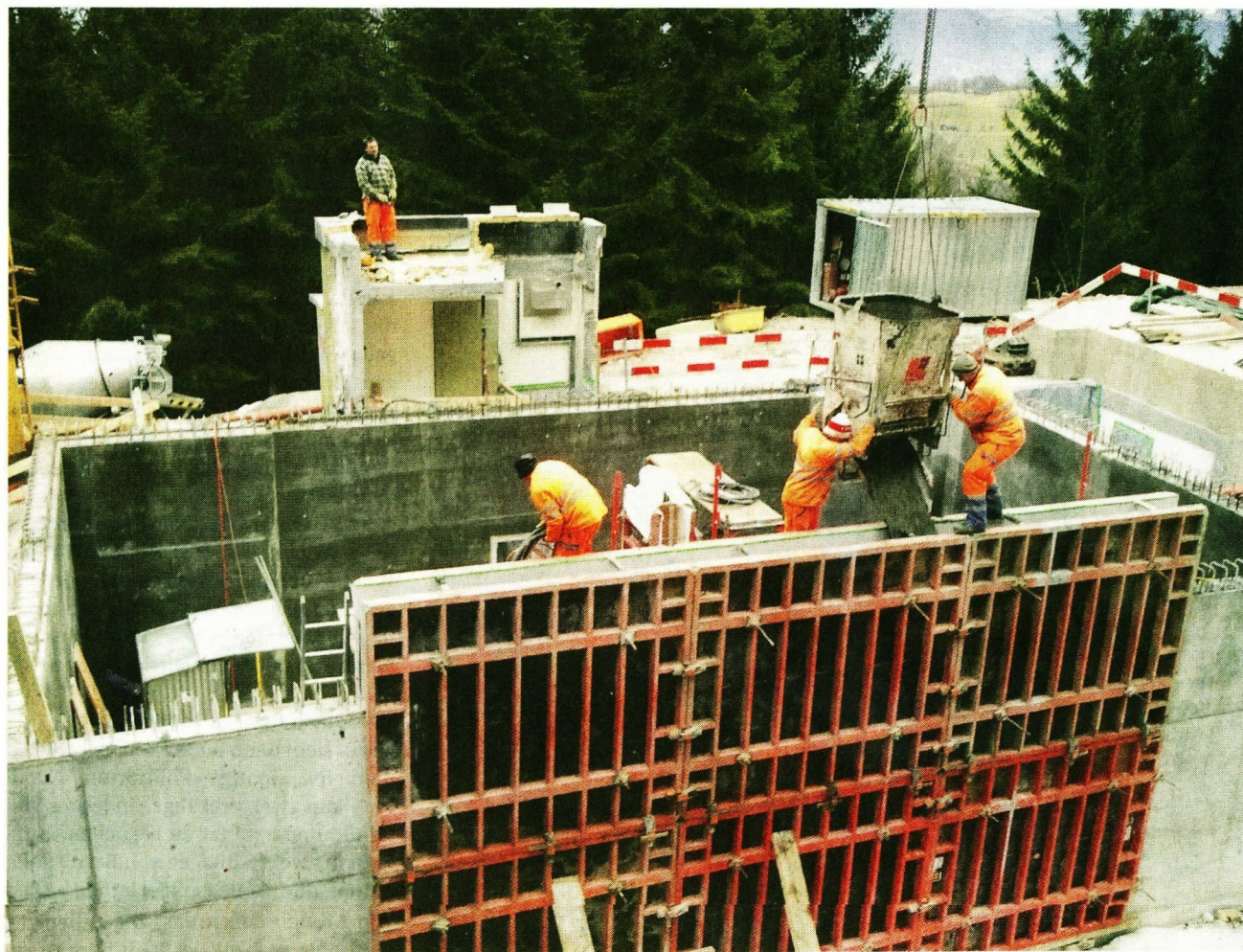
Bauarbeiten an dem Reservoir Oberstocken.
