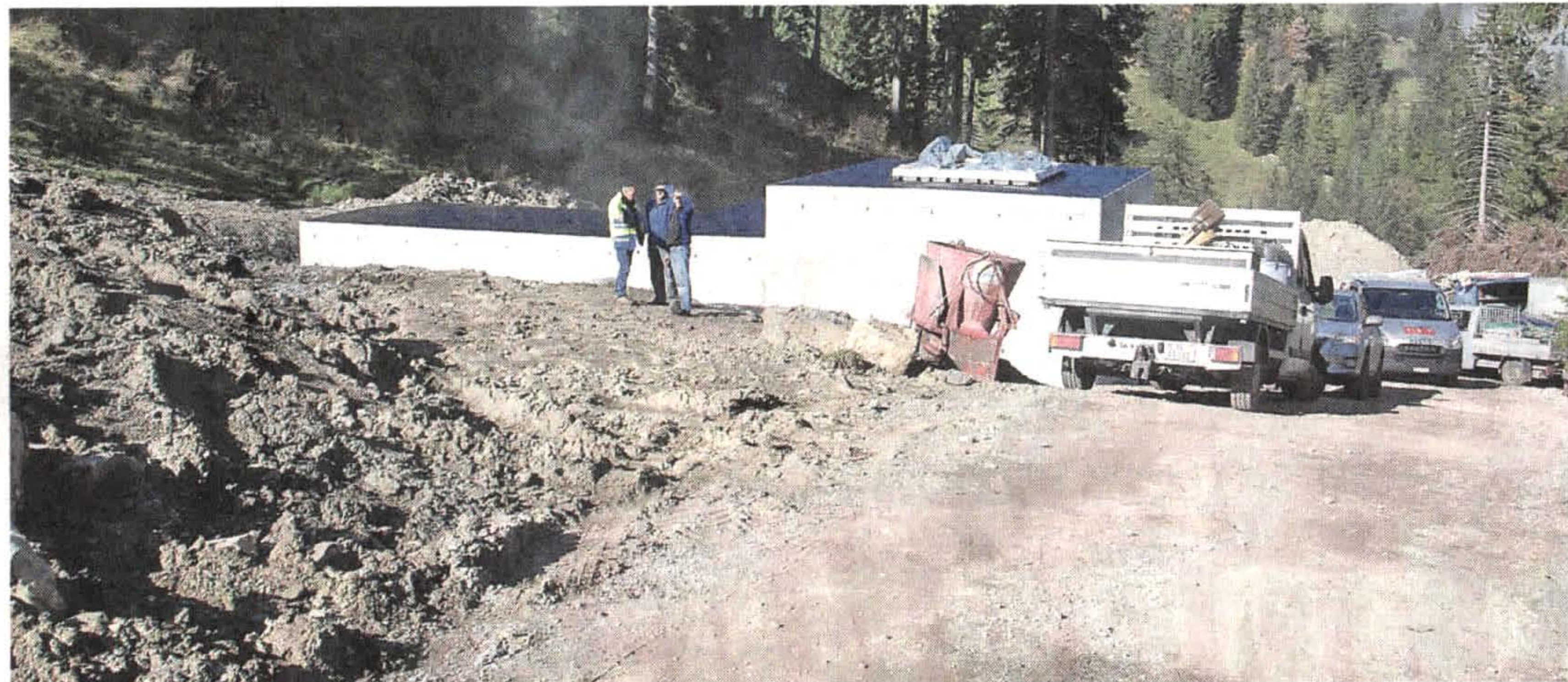
Das Gebäude der Wasserversorgung Blattenheid auf der gleichnamigen Alp oberhalb von Blumenstein.
