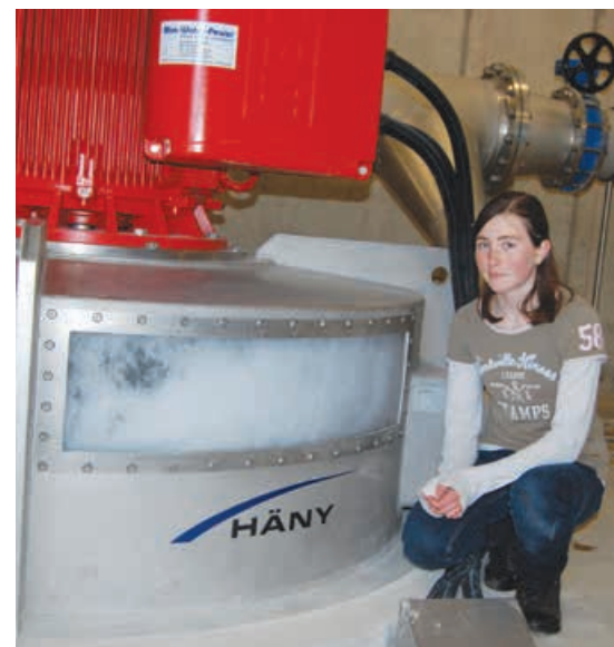
Das Wasser wird gezähmt: Turbine unterhalb der Brunnstube Blattenheid.
