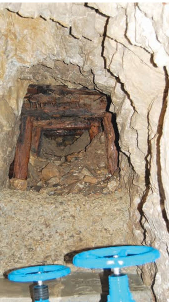
Ursprüngliche Pionierleistung von 1913 in einem Seitenstollen der Blattenheid-Quellfassung.
