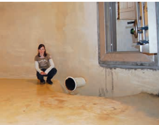
Das leere Wasserreservoir in Thierachern im Umbau.
