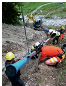
Rohrleitungsbau Spycherweg mit Unterstützung des Helikopters auf 1'400 m ü. M.
