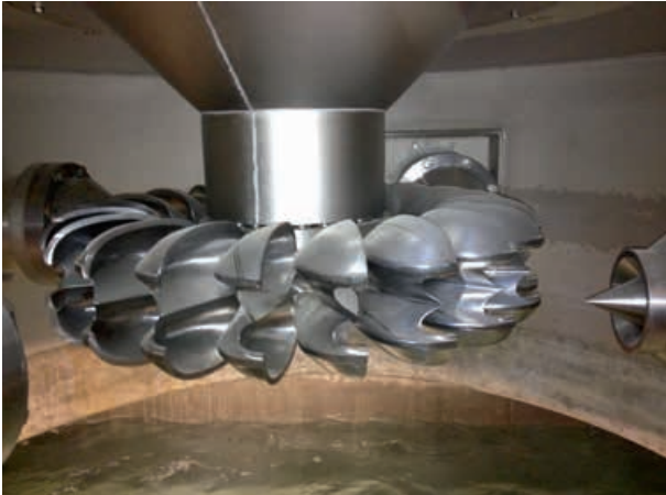
TWKW Blattenheid – stehende Pelton turbine mit Düse.
