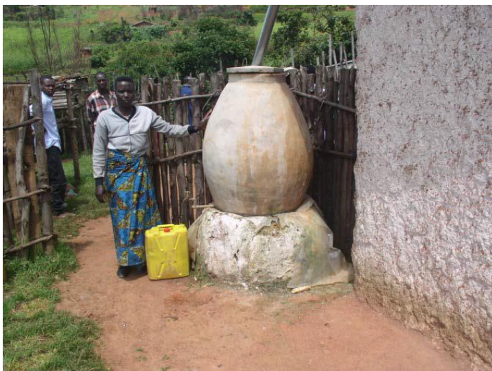
Die TearFund Partnerorganisation bildet lokale Handwerker im Bau von kleinen Wassertanks aus.
