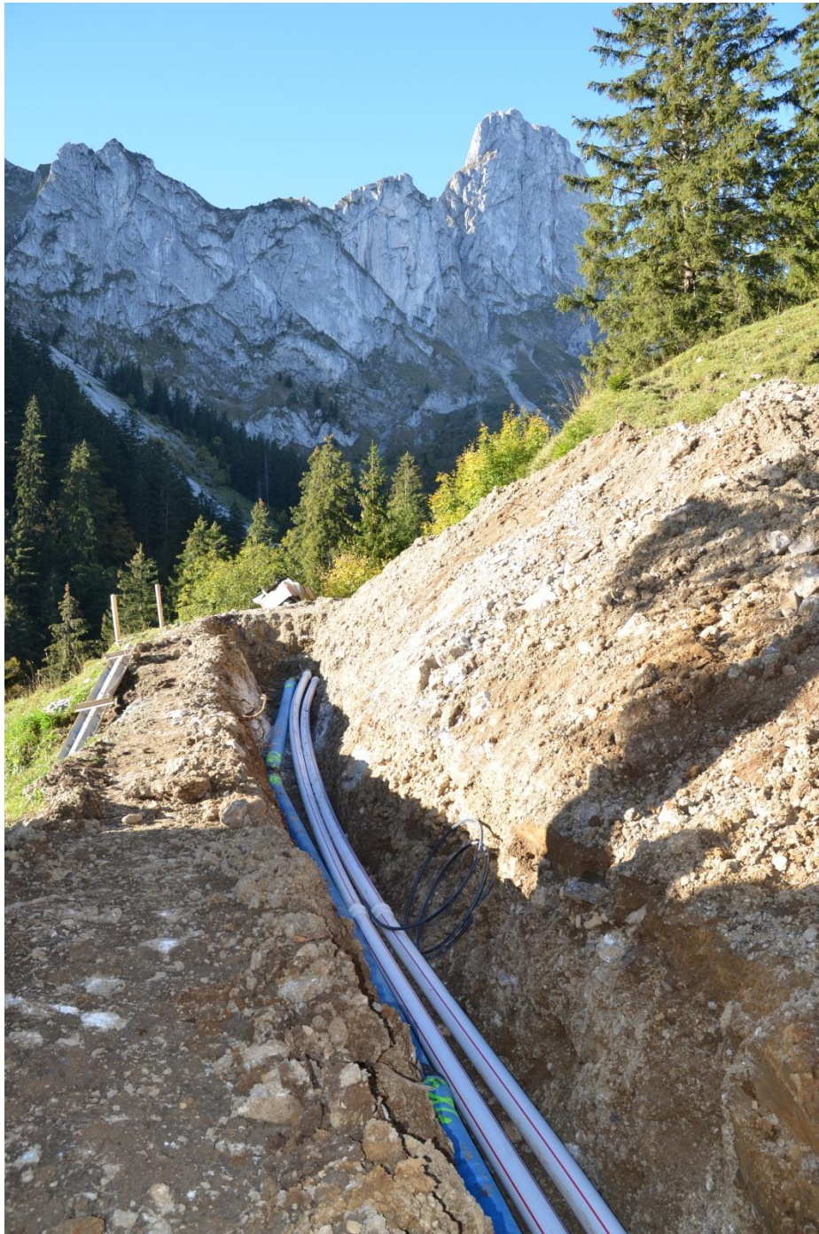
Leitungsbau Baachalp Sommer 2011 Spycherweg bis vordere Schneeweid
