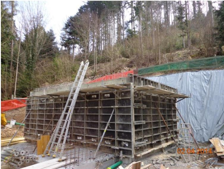
Die Arbeiten für das Stufenpumpwerk starteten im Februar 2014 mit den temporären Rondungsarbeiten durch die Burggemeinde Thun. Ab dem 3. März erfolgte der Voraushub durch die Subunternehmung Isenschmid AG. Die Rohbauarbeiten durch HTH konnten am 17. März begonnen werden und dauerten bis Ende April. Anschliessend wurden die äusseren Abdichtungsarbeiten und die Hinterfüllung ausgeführt.
