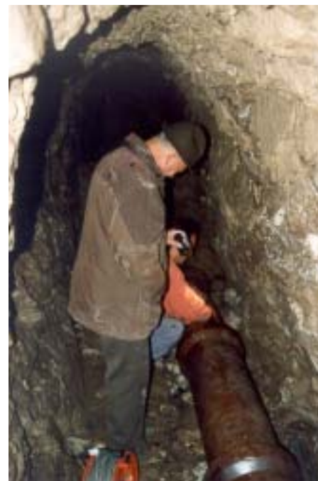
Abb. 8: Ortung der alten Tonrohrleitung
