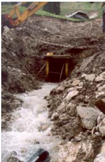
Abb. 5: Grabungsarbeiten mit Freilegung des Stolleneingangs
