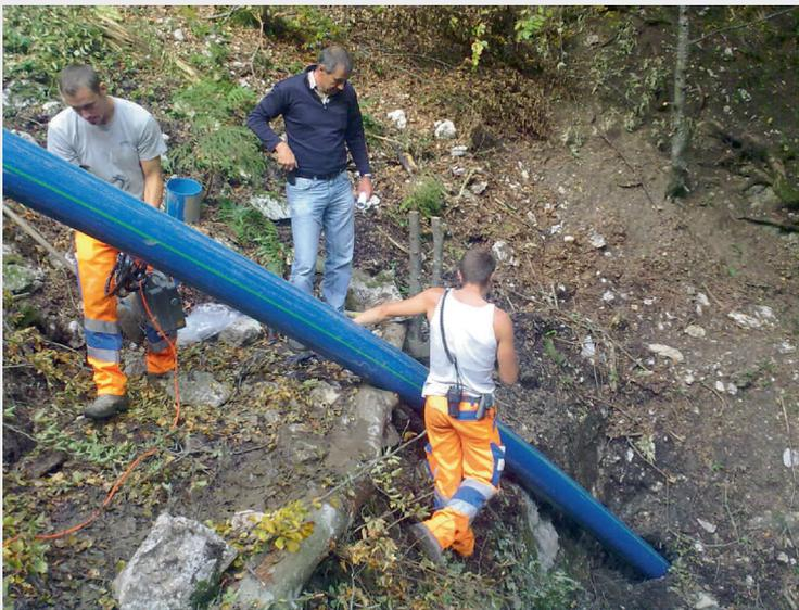
Fig. 4 Einzug der PE-Druckleitung in die 265 m lange Bohrung für das Kraftwerk Oberstocken
