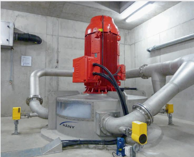
Fig. 3 Pelton-Turbine im Kraftwerk Blattenheid mit Schauglas
