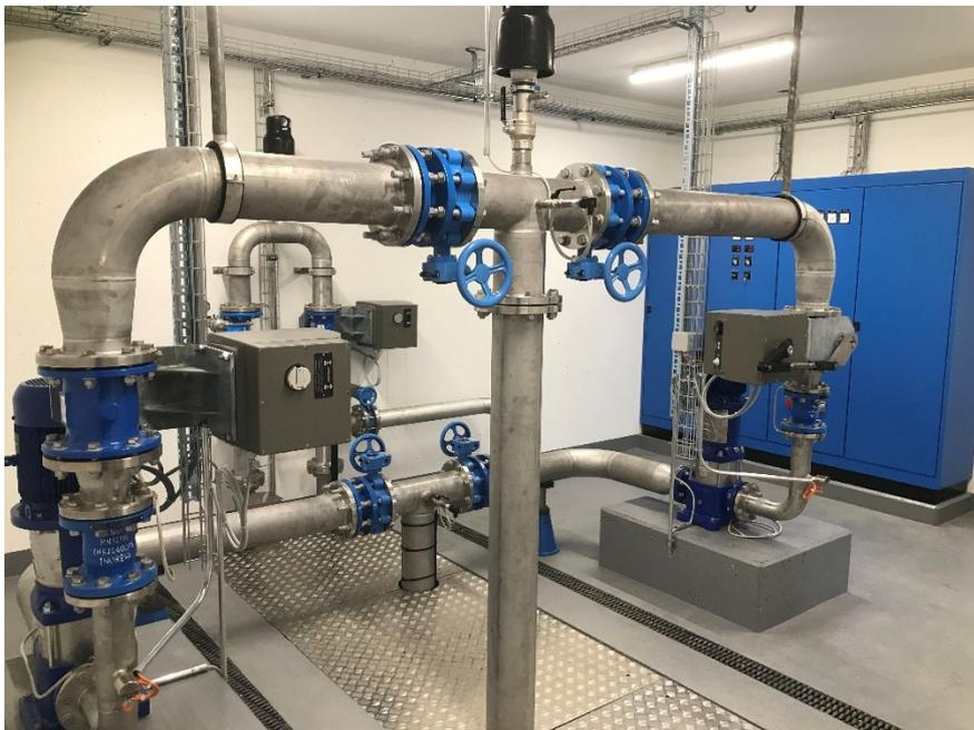
*Zwei Pumpen und Armaturen und Steuerung im Stufenspumpwerk Oberdiessbach*
