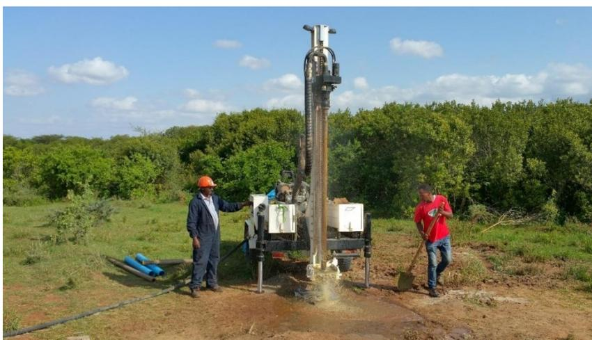
*Nach erfolgreicher Bohrung erfolgt das Spülen. Diese Reinigungsmethode ist eine unerlässliche Voraussetzung, um eine Verstopfung der Brunnen vorzubeugen und deren Lebensdauer auf ein Maximum zu erhöhen*
