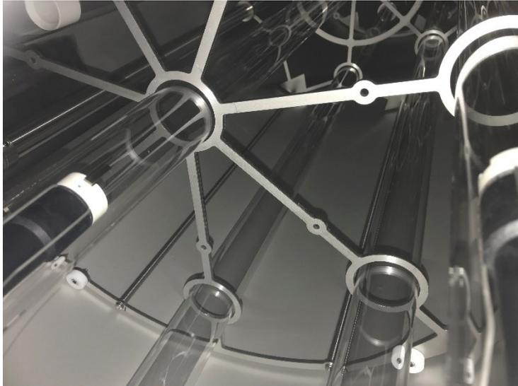
*Blick in das innere des UV Reaktors zeigen die Schutzgläser, welche dann die UV-Lampen aufnehmen.*
