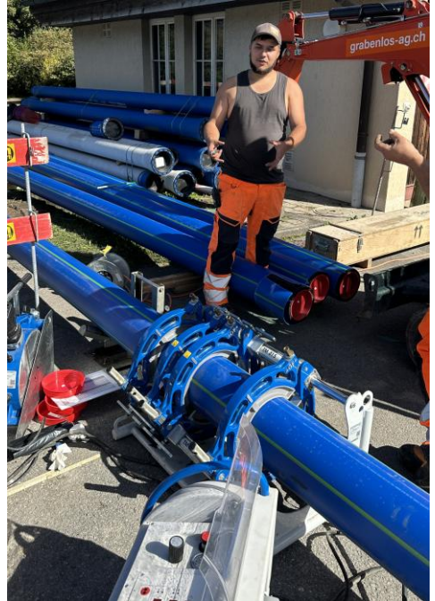
Schweissung der PE-Leitung für den Einzug
