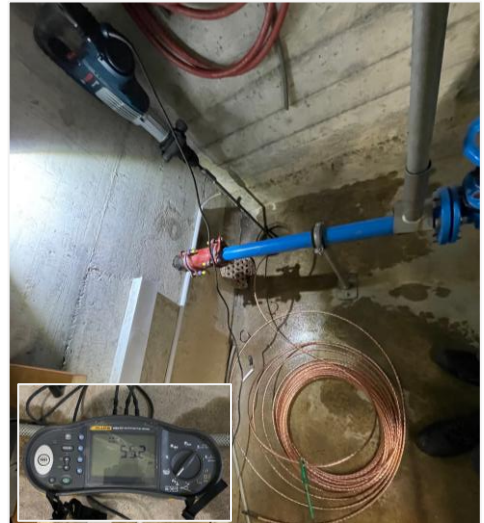
Instandstellung Tiefenerdungen
