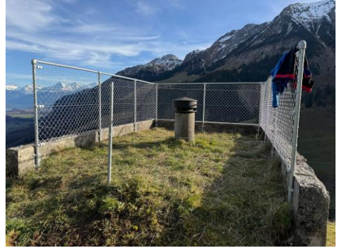
Zaun zur Absturzsicherung (Langenegrain)
