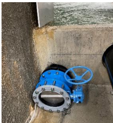
Wartungsarbeiten an Schieber und Klappen
