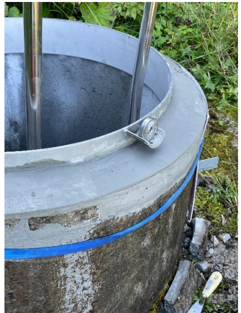
Reparaturarbeiten am Einstiegsring
