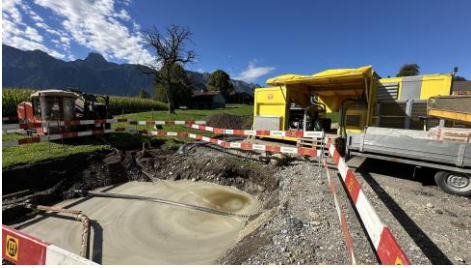
Spülbohrung Abzweigung Weidliweg
