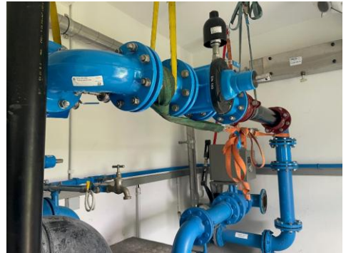
Provisorische Bypass der Einlaufklappe
