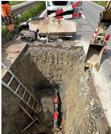
Leitungsbruch in Oppligen Kantonsstrasse
