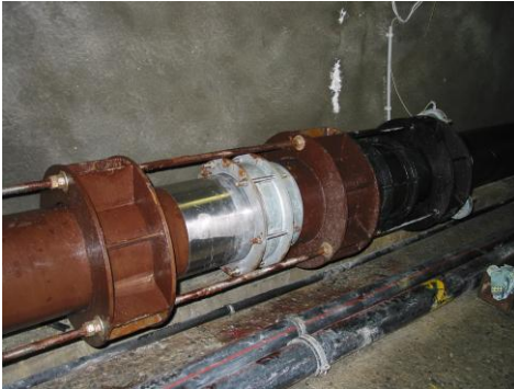
Teleskoprohrsystem Druckleitung
