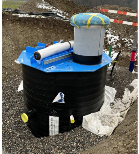
Druckreduzierschacht
