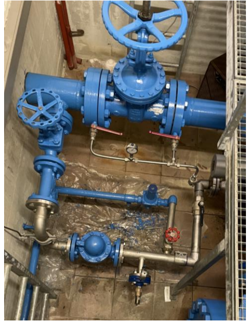
Druckreduzierventil (unten Mitte)
