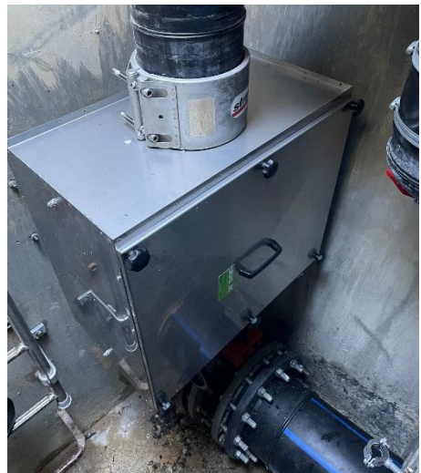
Neuer Luftfilter in der Sammelbrunnstube
