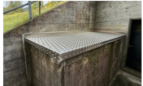
Neue Abdeckung Südportal Stollen Langenegg
