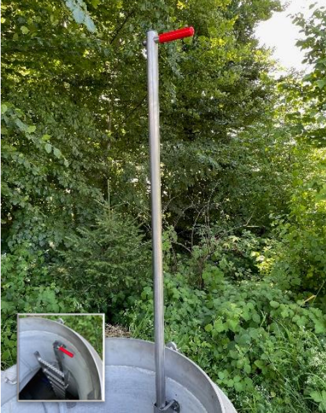
Ausziehbare Schacht - Einstiegshilfe
