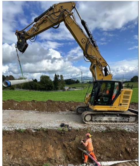
Verlegung Transportleitung DN200 in Thierachern
